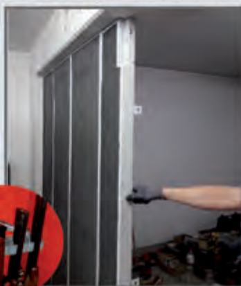
Aufrüstung von Räumen zu gleichwertigen Waffenräumen
