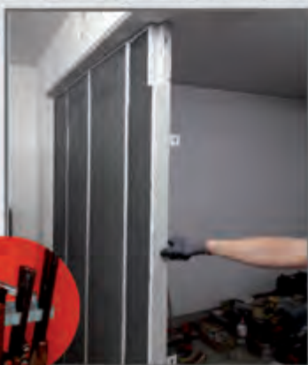
Aufrüstung von Räumen zu gleichwertigen Waffenräumen
