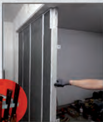
Aufrüstung von Räumen zu gleichwertigen Waffenräumen
