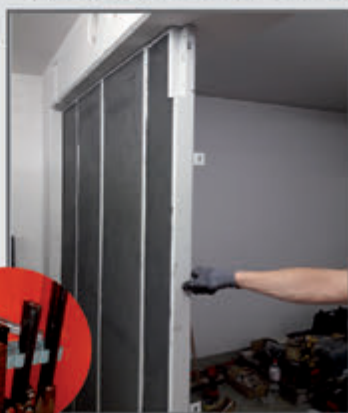
Aufrüstung von Räumen zu gleichwertigen Waffenräumen
